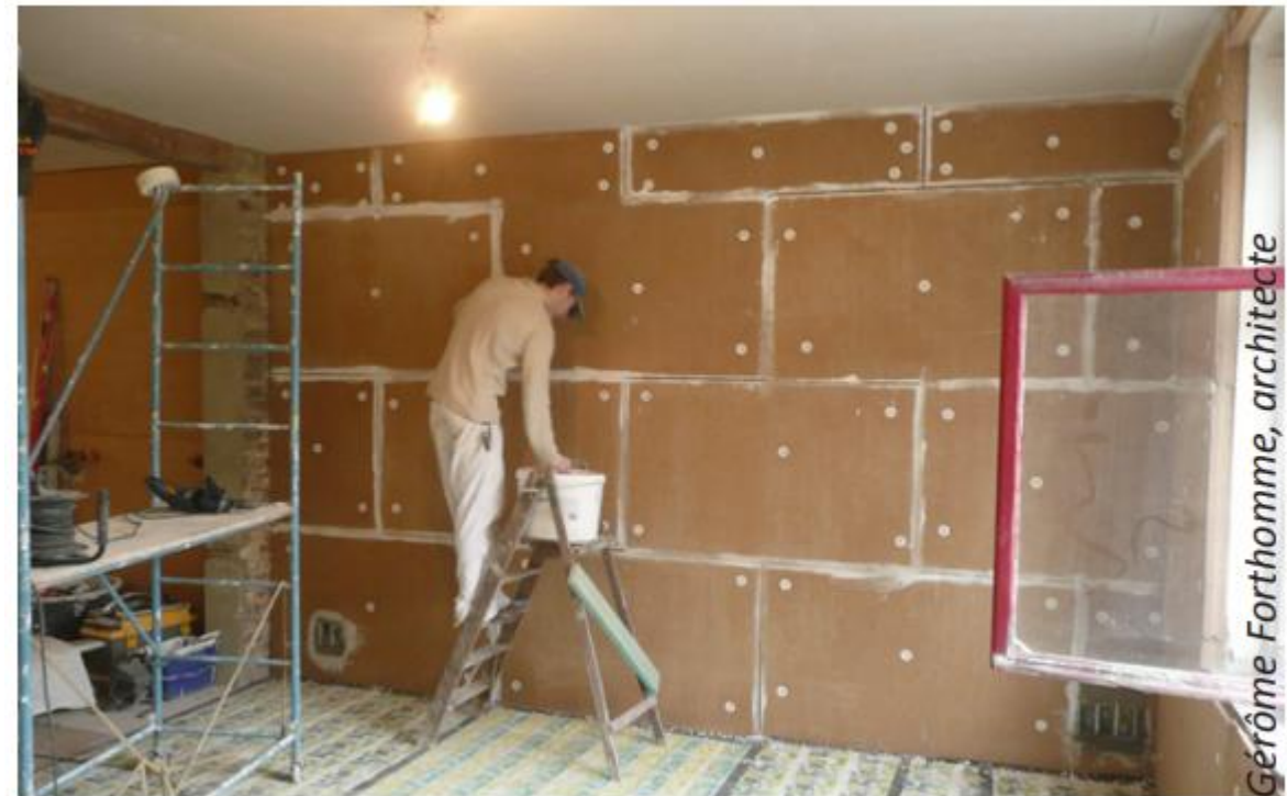
Isolation réalisée à l'aide de panneaux de fibre de bois.
